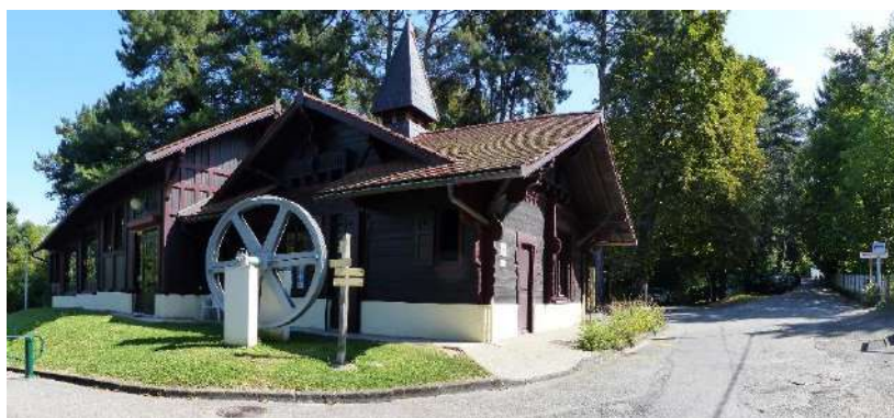
Gare amont du funiculaire d'Evian, en entrée de Neuvecelle – Source : KARUM, 2021
