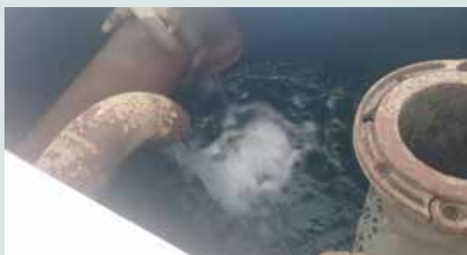
Réservoir des Tours
